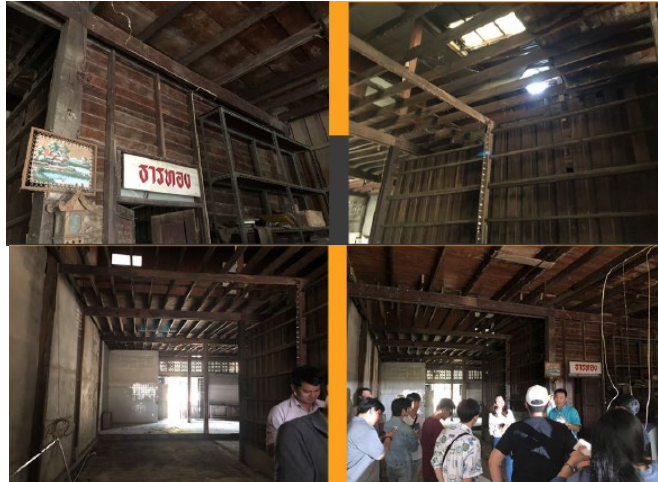
รูปที่ 2 การเข้าสำรวจอาคารกรณีศึกษาของคณะนักศึกษาพร้อมกับเจ้าของโครงการและทีมงานวิศวกร
