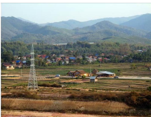
รูปที่ 4 เสาส่งไฟฟ้าแรงสูงผ่านชุมชนโรงไฟฟ้าหงสา
