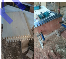
รูปที่ 19 การทำเดือยไม้และการเข้าเดือยไม้สำหรับการประกอบขึ้นโครงสร้างเพื่อความแข็งแรง และความสวยงาม
