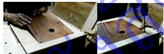
รูปที่ 27 การติดตั้งเร้าเตอร์
