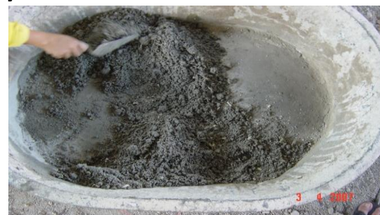
รูปที่ 4 ทำการผสมน้ำลงไปเล็กน้อยให้พอหมาด
